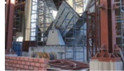
Çimento Fabrikası Sistem Fanı 260.000 m 3 /h - 382 mmSS
