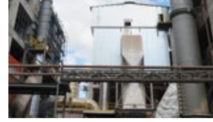
Çimento Fabrikası Klinker Filtre Fanı 750.000 m 3 /h - 480 mmSS
