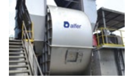
Çimento Fabrikası ESP Fanı 1.057.373 m 3 /h - 305 mmSS
