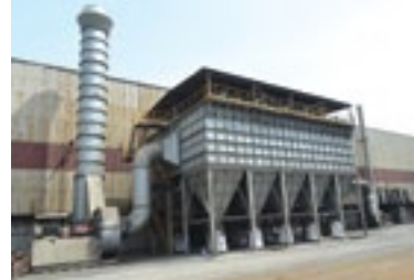
Döküm Fabrikası Filtre Fanı 150.000 m 3 h - 550 mmSS
