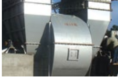
Çimento Fabrikası ESP Fanı 403.00 m 3 /h - 300 mmSS
