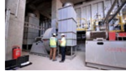
Çimento Klinker Soğutma Fanları 25.000-80.000 m 3 /h - 1100 mmSS
