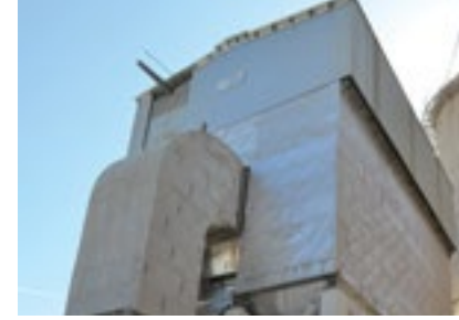
Çimento Farin Fırın Torbalı Filtresi 508.000 m 3 /h
