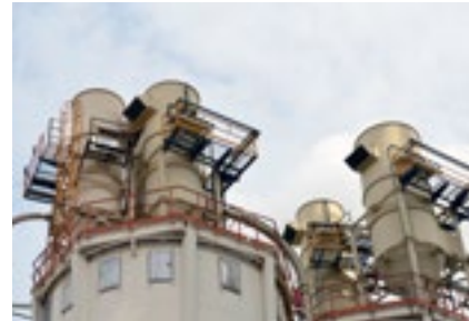
Ağaç Entegre Siklonik Filtreler 5.000 m 3 /h
