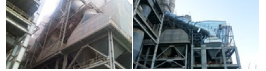
Çimento Farin Fırın ESP Dönüşüm 650.000 m 3 /h
