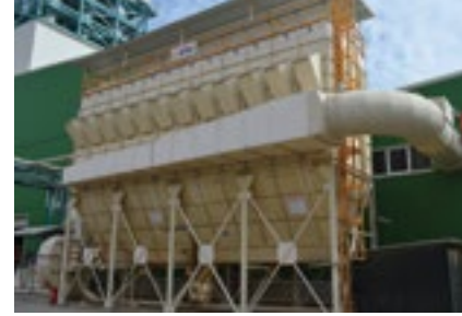
Ağaç Entegre Tozsuzlaştırma Torbalı Filtresi 110.000 m 3 /h
