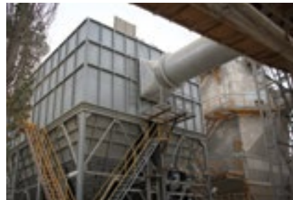
Maden Manyezit Tozsuzlaştırma Torbalı Filtresi 200.000 m 3 /h
