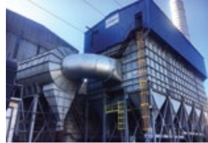
Demir ve Çelik Fabrikası İndüksiyon Fırını Toz Toplama Filtresi 600.000 m 3 /h
