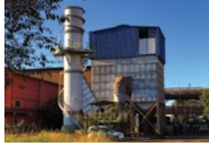
Demir ve Çelik Fabrikası Sinter Hammadde Stoklama Tesisi Torbalı Filtresi 275.000 m 3 /h
