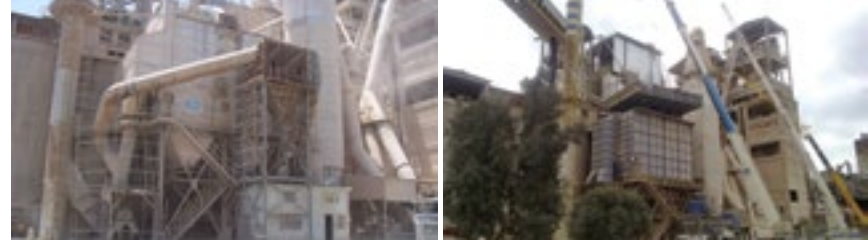
Çimento Farin Fırın ESP Dönüşüm 220.000 m 3 /h
