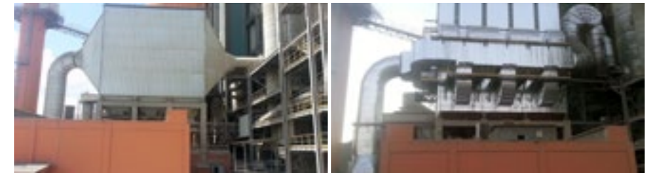
Çimento Farin Fırın ESP Dönüşüm 647.000 m 3 /h
