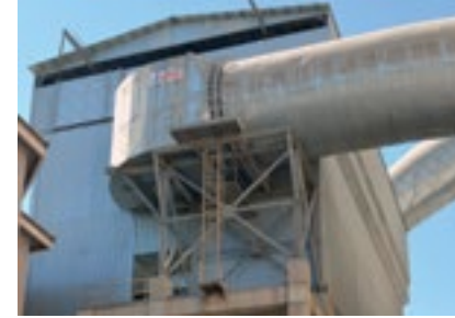
Çimento Farin Fırın Torbalı Filtresi 900.000 m 3 /h
