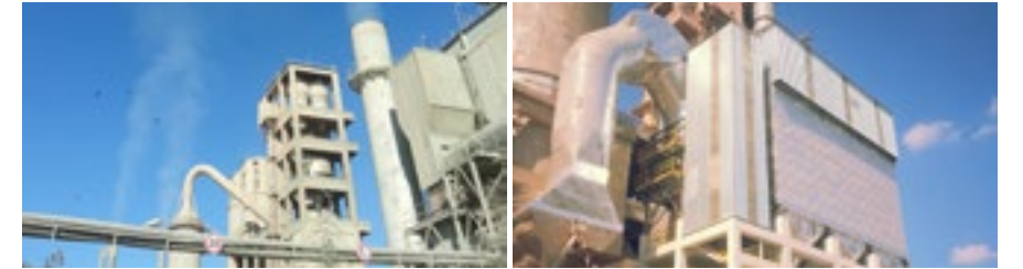
Çimento Farin Fırın ESP Dönüşüm 508.000 m 3 /h
