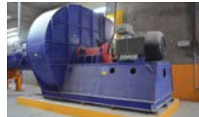
Завод По Производству Удобрений 53.000 м 3 /ч – 550 mm WC
