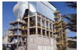
Цементный Завод – Для Фильтра Цементного Мельницы 610.000 м 3 /ч – 705 mm WC
