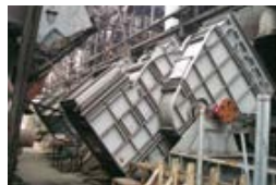
Металлургический Завод 381.641 м 3 /ч – 584 mm WC
