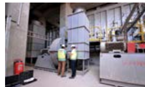
Цементный Завод – Вентилятор Для Охлажденного Клинкера 25.000 - 80.000 м 3 /ч – 1.100 mm WC
